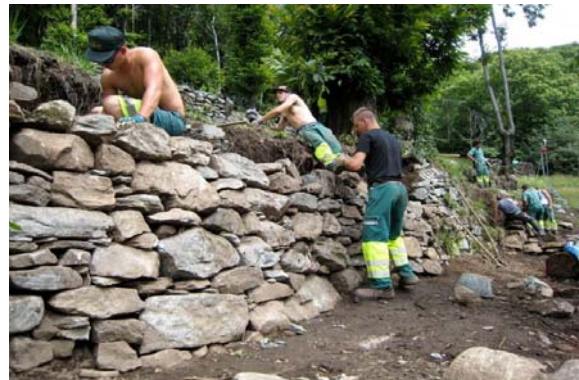
Abbildung 3: Jugendliche bei der Sanierung einer Trockenmauer
